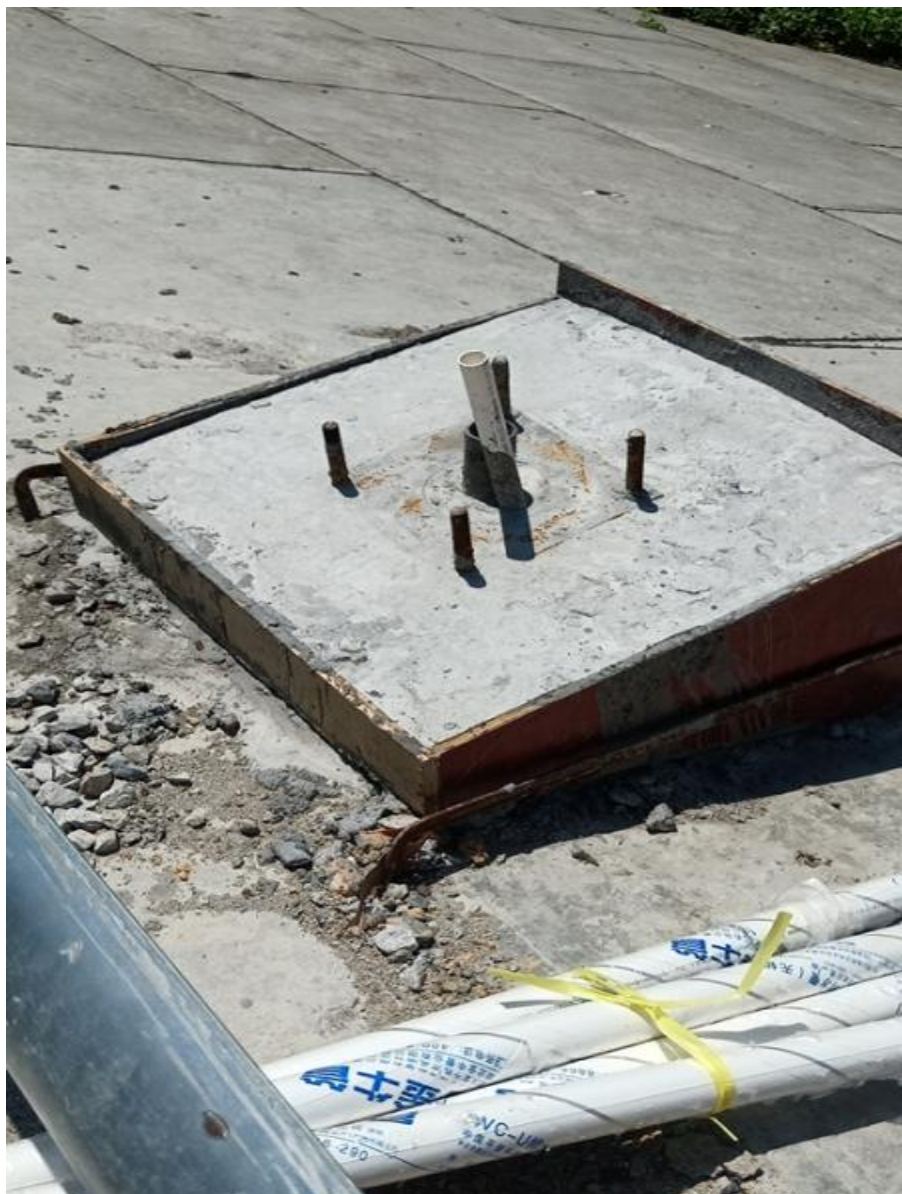
图 2.5-1 立杆基础图片
