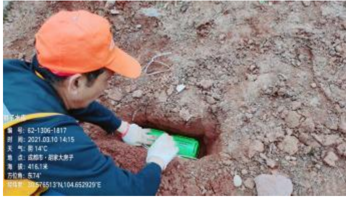
图 2.3-1 白蚁信息索引诱装置安装图
